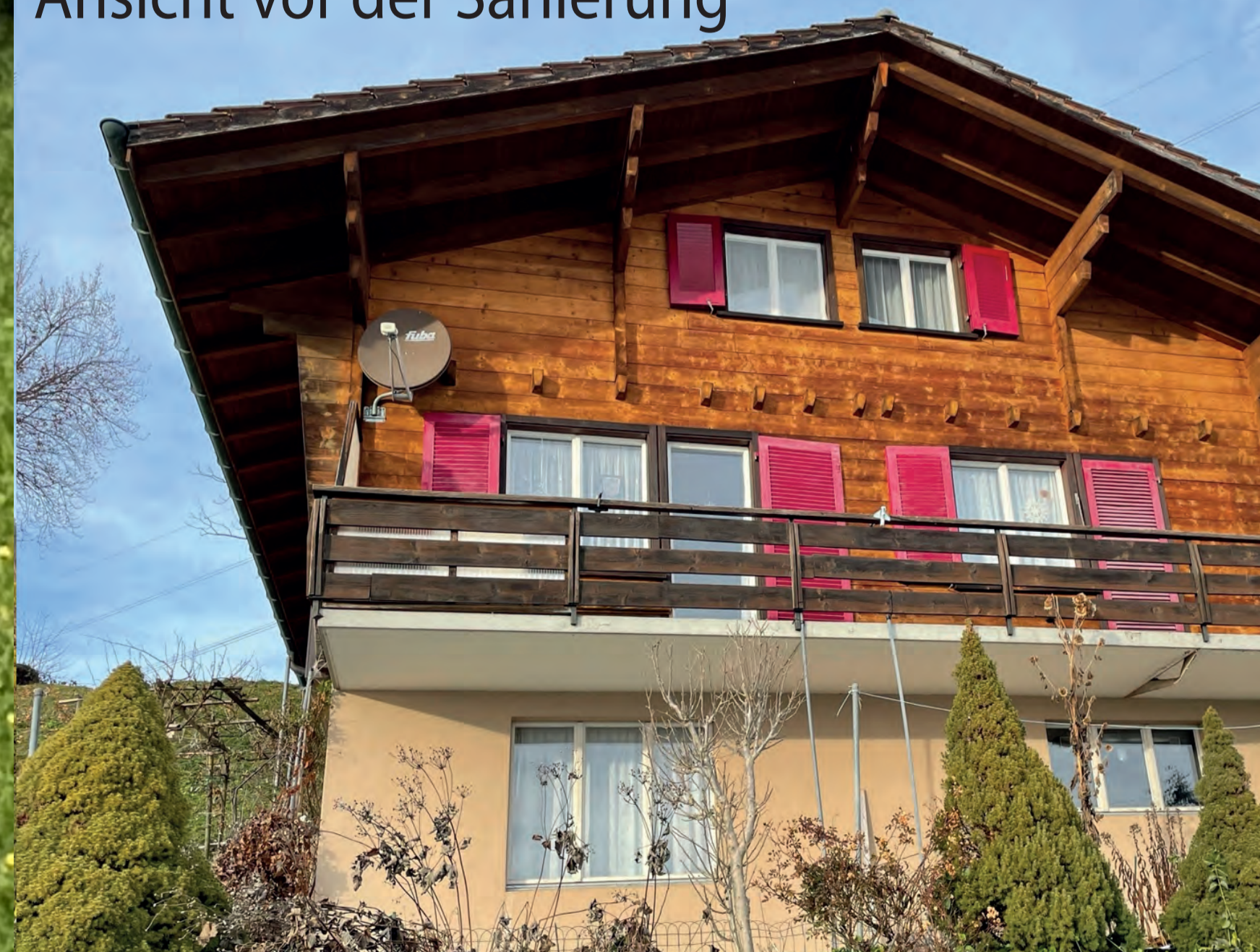
Ansicht vor der Sanierung
